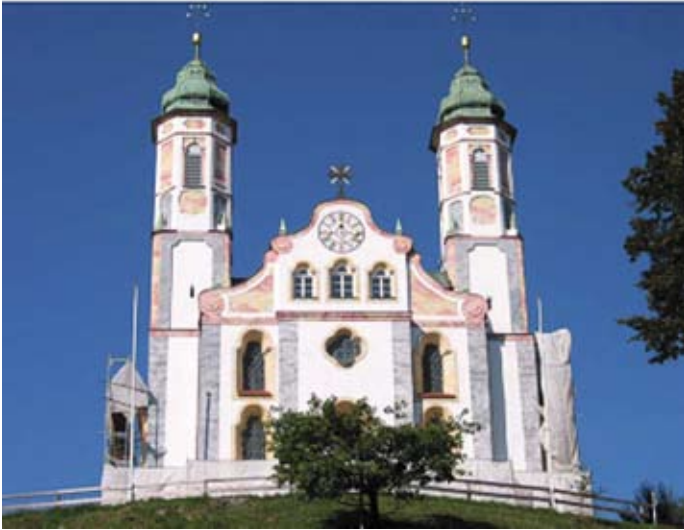
Abb. 18: Die fertiggestellte Fassade im September 2006.
